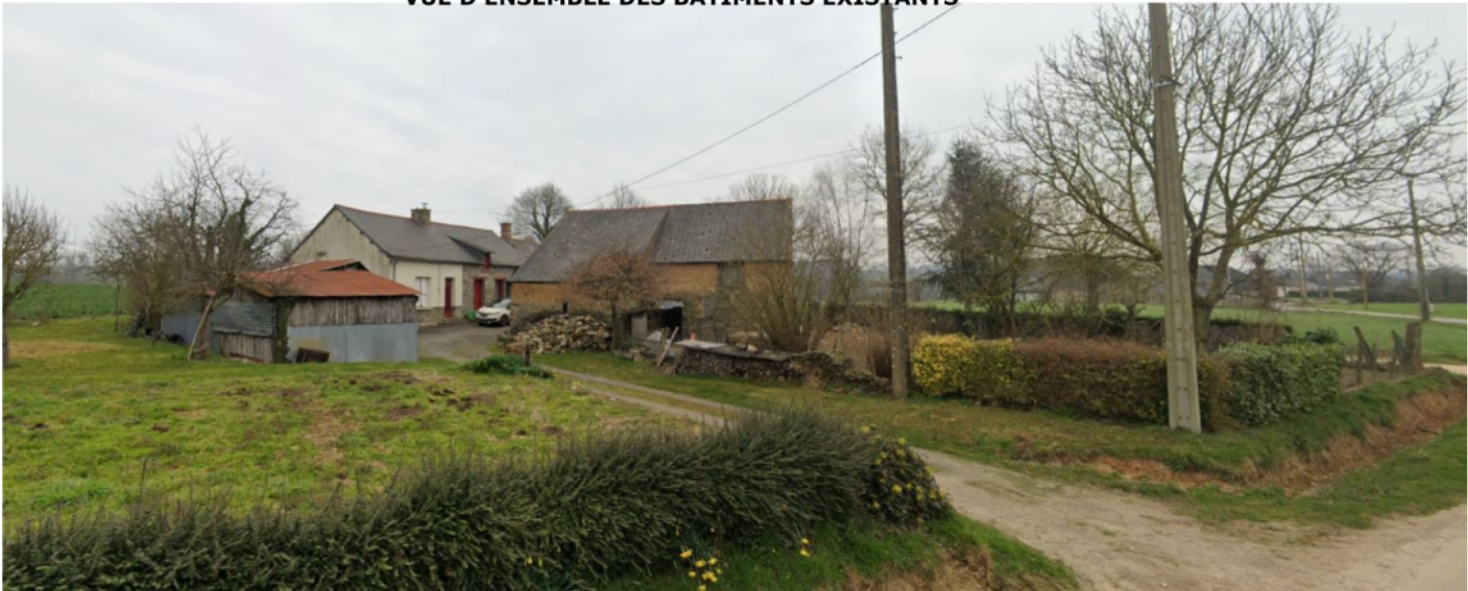
VUE D'ENSEMBLE DES BÂTIMENTS EXISTANTS
